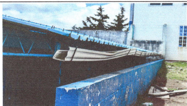
Foto 9: sustitución de canales de pvc. Modulo 3 de aulas
