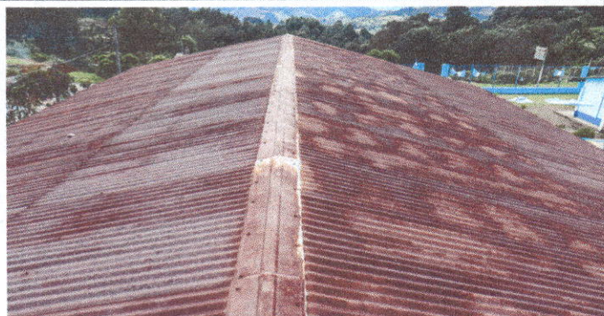
FOTO 1. Sustrucción de lámina, por lámina troquelada calibre 26, sustrucción de capote de lámina para lámina troquelada, sustrucción de elementos de fijación. Modulo 1 de aulas.
