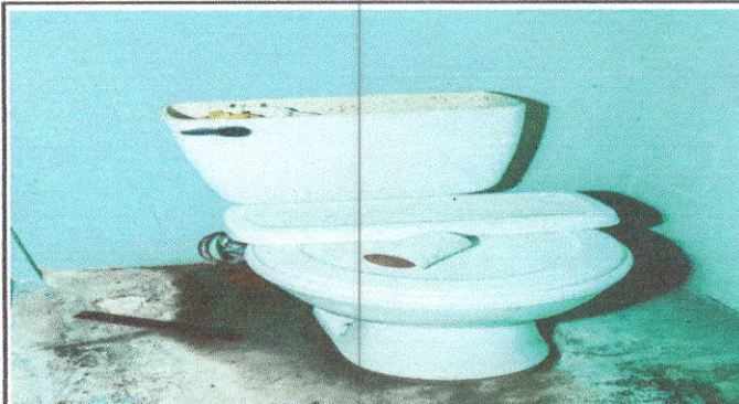
Foto 4: sustrucción de inodoros modulo de baños.
