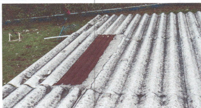
Foto 2: Sustrucción de lámina, por lámina troquelada calibre 26, sustrucción de capote de lámina para lámina troquelada, sustrucción de elementos de fijación. Modulo 2 de aulas.
