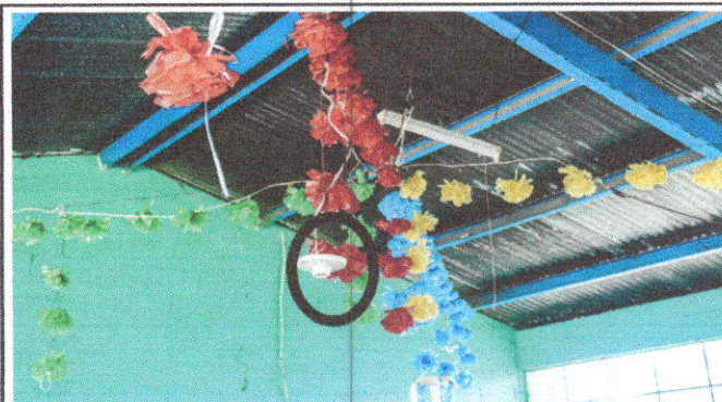
Foto 10: sustitución de foco ahorrador modulo 1 de aulas.
