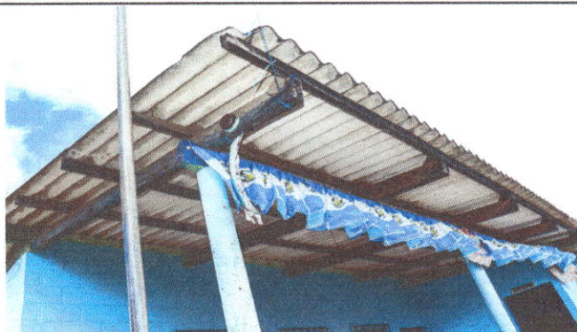
Foto 3: sustrucción de estructura de soporte de madera, por metal modulo 2 de aulas.
