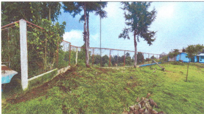
Foto 6: reparación de muro perimetral de block con tubo ng y malla garbanizada, soleras intermedias y columnas.
